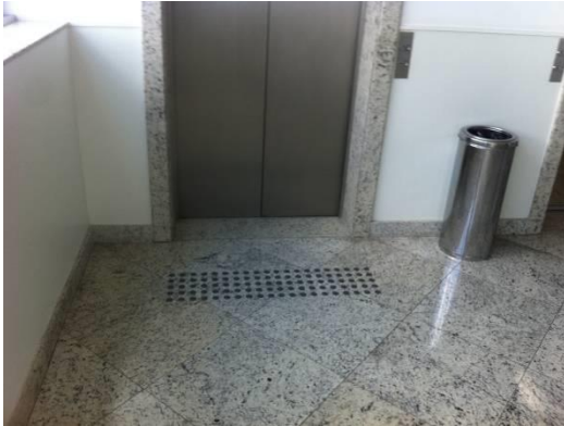
Figura 5 - Entrada dos elevadores com indicadores táteis 1 (Unidade II) – Todos os andares seguem o mesmo padrão
