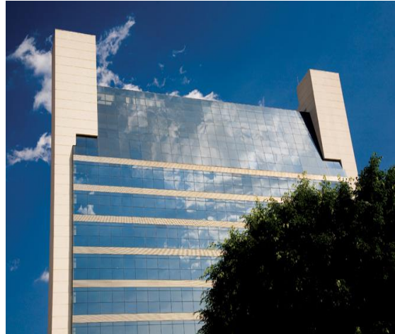
Figura 2 - Vista lateral do prédio (Unidade II)
