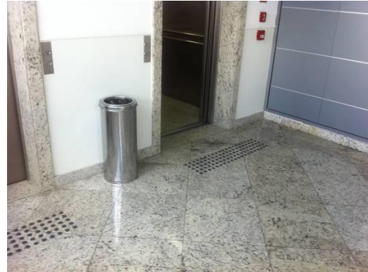
Figura 6 - Entrada dos elevadores com indicadores táteis 2 (Unidade II) – Todos os andares seguem o mesmo padrão
